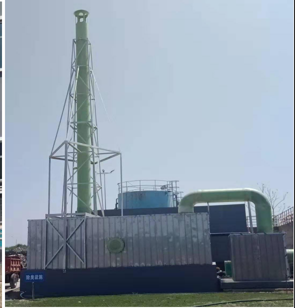
生物除臭设施
