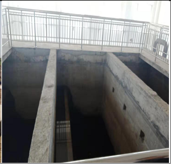
深度处理车间滤池
