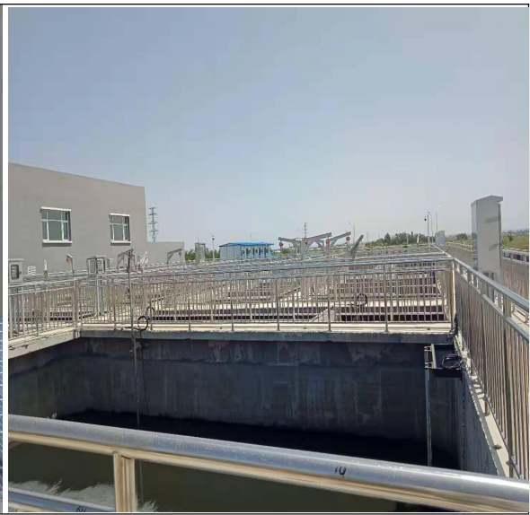
调节池及生化池
